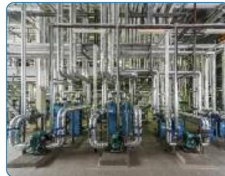
welche die im Prozess befindlichen Medien in hohe Turbulenzen versetzen, hieraus resultiert ein hoher Wärmeübergangswert. Für eine optimale Leistungsübertragung und geringe Temperaturdifferenzen müssen die beiden Medien im reinen Gegenstromprinzip geführt werden.
